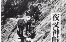
土封鎖の現場で力を合わせて土留めの丸太を設置する作業者たち。
